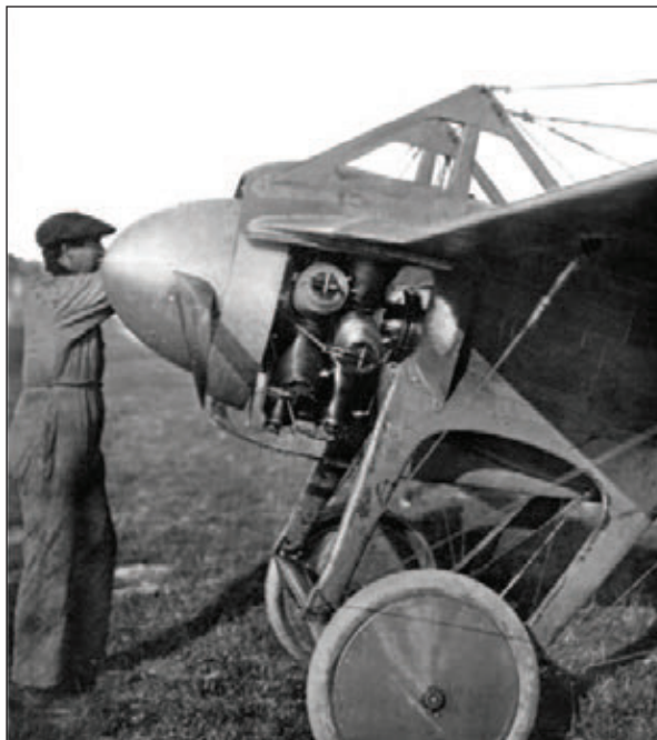
САМОЛЕТ-РЕКОРДСМЕН: Deperdussin с двигателем Gnome мощностью 160 л.с. установил в 1913 г. рекорд скорости
